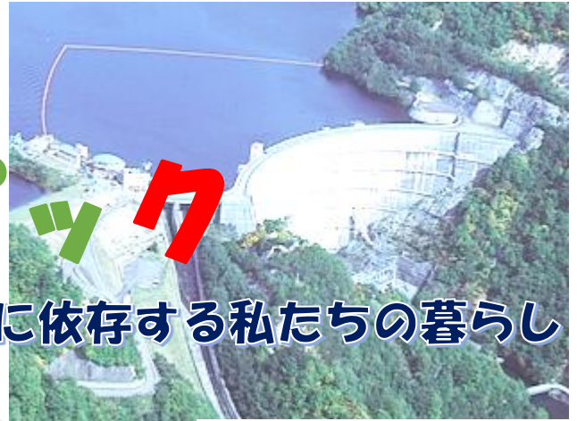
(独)水資源機構 HP より、矢木沢ダム
